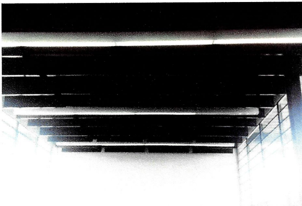
Antes – salas de atendimento sem proteção luz
