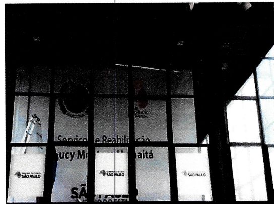
Depois - proteção evitar entrada de chuva
